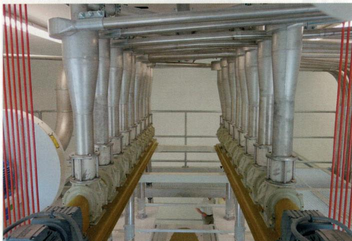
Abb. 4: Für die hohen Hygieneanforderungen wurde die gesamte Mühlenpneumatik in Edelstahl ausgeführt.
